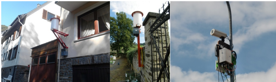
Abb. 1: Monitoring - Installationen in der Cochemer Oberstadt
